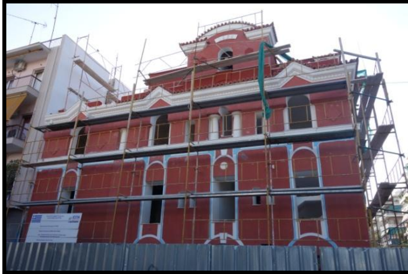
Το Κόκκινο Σχολείο σε διαδικασία αναπαλαίωσης.
